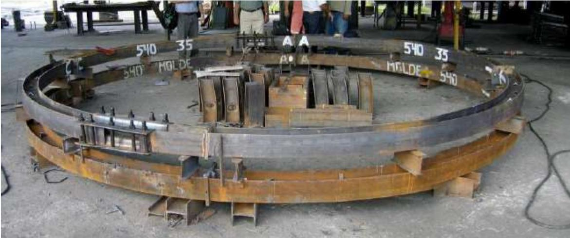
**Figura 3.- La solución de anillos con diámetros ajustables toleró las deformaciones visco-plásticas del terreno (Fuente: Hoek and Guevara, 2008)**
