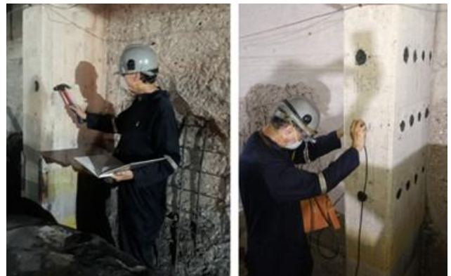
Figura 45. Ensayos no destructivos. Prueba táctil-auditiva (izq.); Ensayo de ultrasonido (der.)
