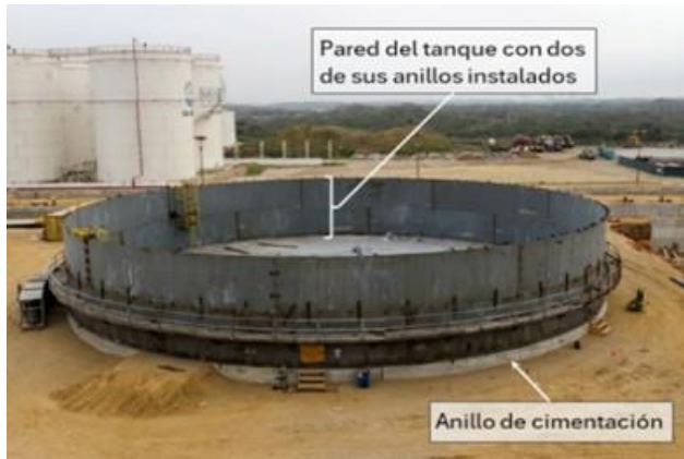
Figura 31. Tanque en construcción
