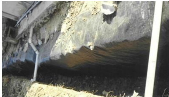
Figura 84. Barrera vertical de 1,8 m de altura con lámina de polietileno y geotextil colocada en el perímetro de los edificios
