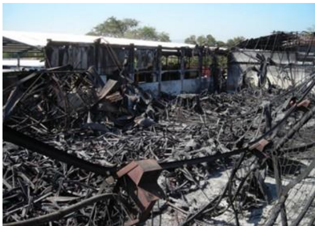
Figura 25. Colapso a causa de incendio de una edificación industrial en estructura metálica no protegida
