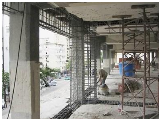
Figura 22. Ejemplo de adecuación sismorresistente de un edificio en Caracas, Venezuela. Se observan técnicas de recrido de columnas y vigas, más confinamiento con sistemas CFRP
