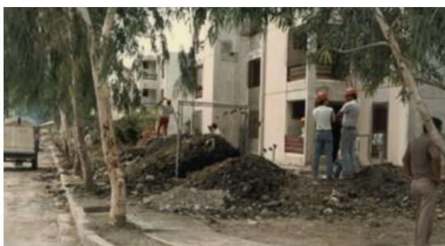
Figura 90. Impacto de vegetación inadecuada paralela al eje de las cimentaciones.
