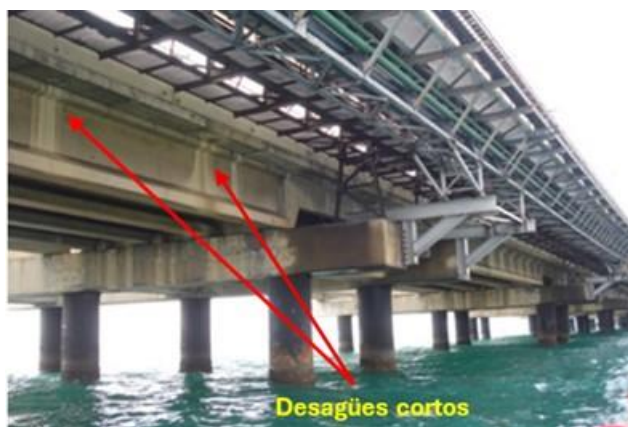
Figura 67. Vista general del Puente de Acceso al Muelle
