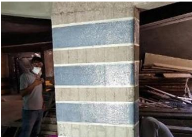
Figura 49. Reparación de daños indirectos en columnas empleando sistema CFRP
