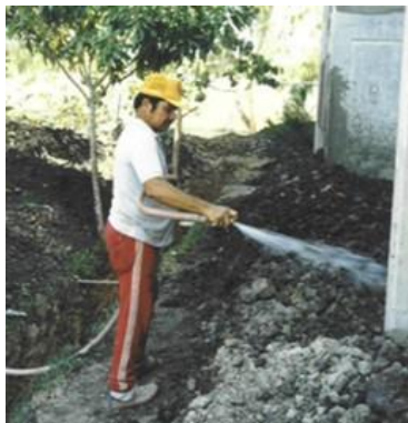
Figura 85. Riego del material de relleno en barreras verticales y horizontales
