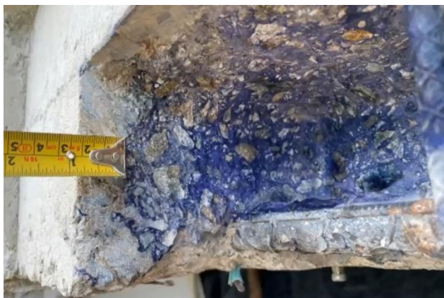
Figura 11. Prueba de carbonatación durante una reparación
