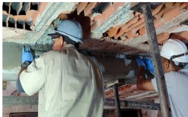
Figura 48. Restitución de secciones de concreto en vigas y losas empleando mortero tixotrópico
