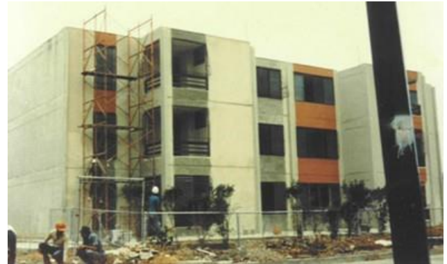
Figura 87. Obra reparada y rehabilitada
