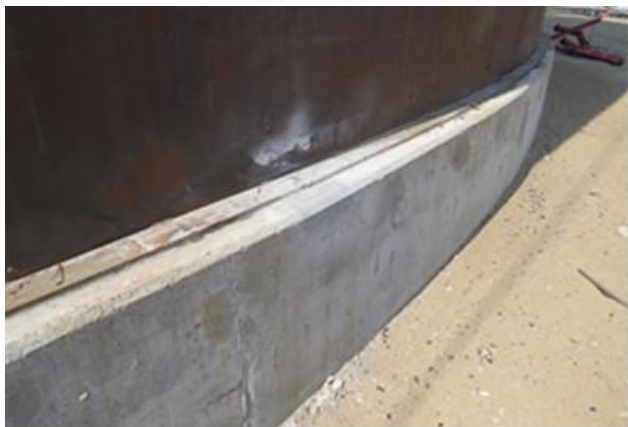
Figura 38. Anillo de cimentación reparado
