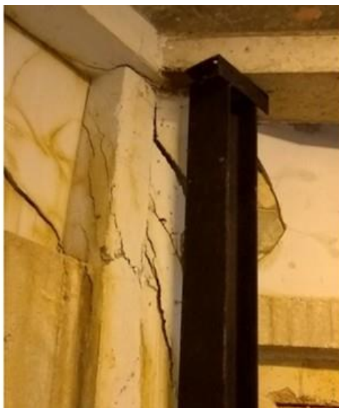
Figura 41. Apuntalamiento preventivo en columna fallada
