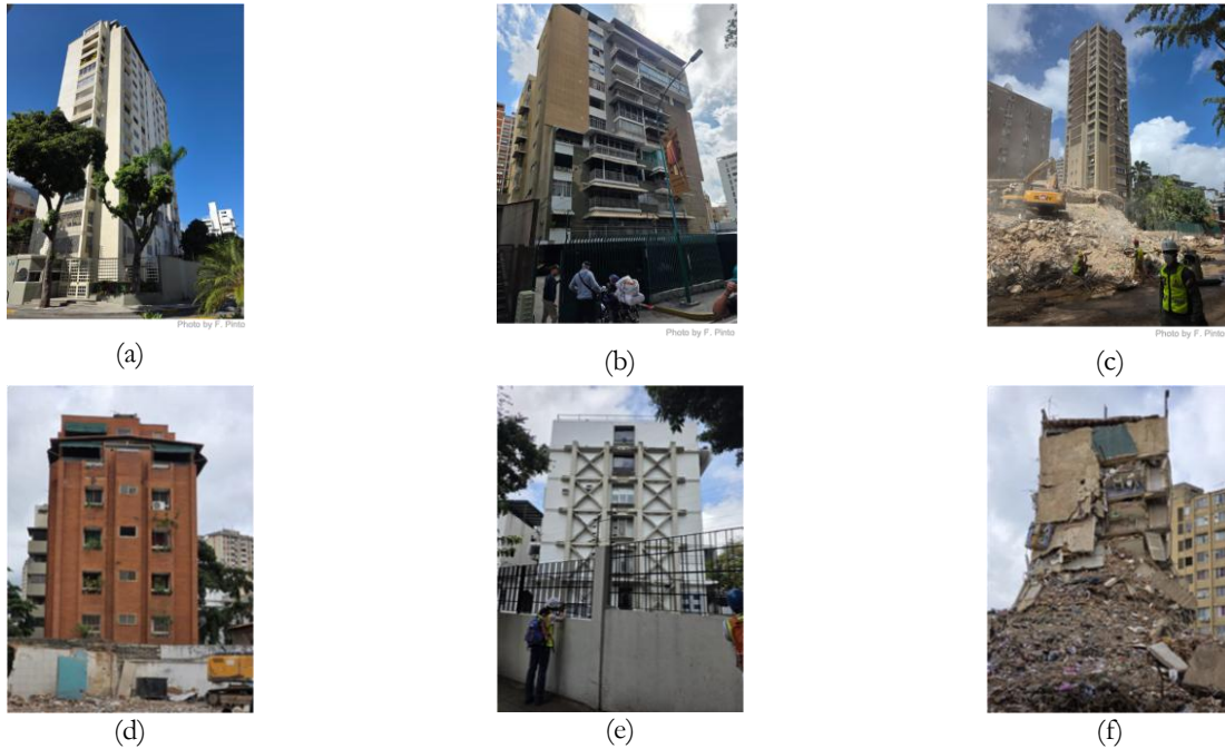
Figura 1. Edificaciones inspeccionadas en Caracas: Los Palos Grandes, (a) torre de unos 16 niveles, (b) edificio de unos 11 niveles con daño de cerramientos y balcones y (c) conjunto Petunia, con el Petunia II de 21 niveles en pie y el área de la torre de 16 pisos colapsada; San Bernardino, (d) y (e) edificios de unos siete niveles, con arriostramiento diagonal exterior en (e), y (f) colapso de una edificación de seis niveles.
