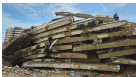
Figura 11.6. Colapso en la OPPPE 26. Foto: L. Hernández.
