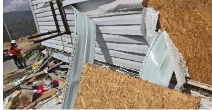
Figura 12.6. Observaciones de campo en las edificaciones de cuatro niveles: daño en elementos y conexiones, anclajes a la fundación, revestimiento y detalles constructivos.
