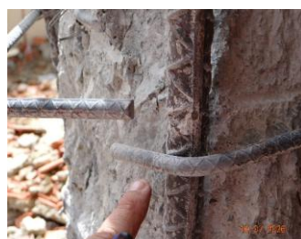
Figura 8.16. Detalle del refuerzo transversal de columna con ganchos a 90°. Residencias Mar Caribe, Caraballeda. Foto: N. Fernández.
