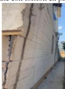
Figura 12.5. Daño observado en las edificaciones de cuatro niveles.
