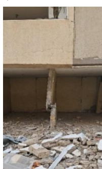
Figura 9.6. Detalle de daño estructural en muros del edificio
