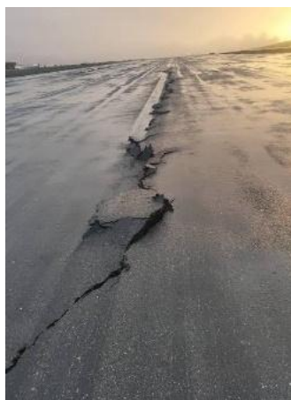
Figura 15.9. Grietas en la pista norte del aeropuerto Simón Bolívar. Esta fractura es pseudo paralela y próxima a la falla de las Bruscas (GEER, 2026).
