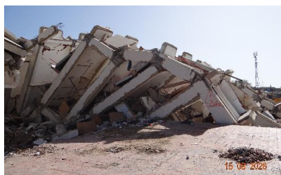
Figura 8.5. Colapso lateral. Edificio Coral Beach, Caraballeda. Foto: N. Fernández.
