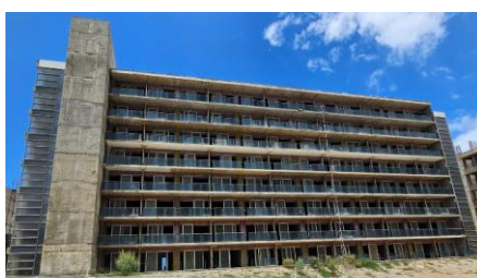
Figura 8.37. Edificio sin daños ubicado en el Estado La Guaira (fotografía M. Hube).
