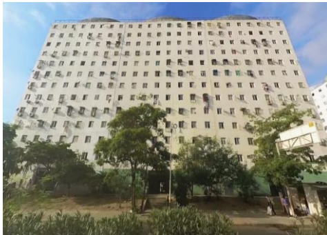
Figura 11.1. Tres torres, separadas por juntas de construcción. Junio de 2024, antes del terremoto. Foto: Google Maps
