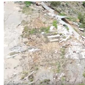
Figura 12.8. Desprendimiento lateral del suelo en el borde del talud, con grietas abiertas en la corona.
