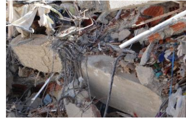
Figura 8.28. Falla de nodo. Edificio Bahía Mar, Caraballeda. Foto: N. Fernández.
