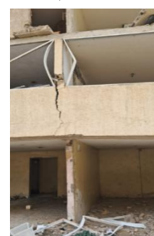
d) Muro Piso 1
