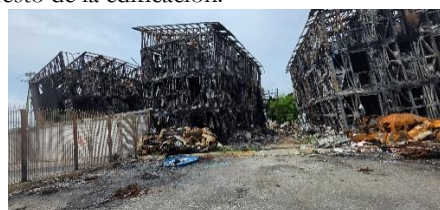
Figura 12.5. Daño observado en las edificaciones de cuatro niveles.
