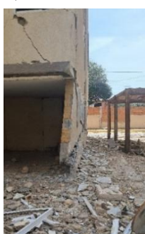
a) Muro lateral PB
