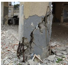
Figura 8.12. Falla por corte de columna. Res. Mediterráneo, Macuto. Foto: N. Fernández.
