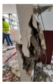
Figura 9.6. Detalle de daño estructural en muros del edificio
