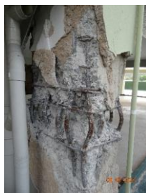
Figura 8.8. Falla por compresión de columna. Torre Las Delicias, Maracay. Foto: N. Fernández.
