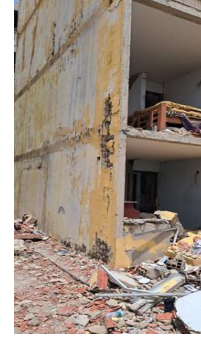
d) Corrosión en muro lateral externo
