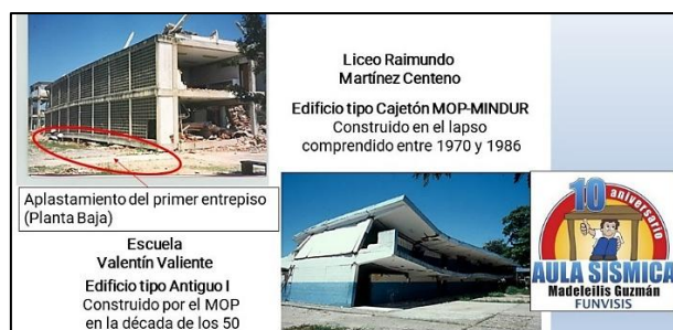
Figura 5 – Colapso de dos escuelas durante el terremoto de Cariaco, estado Sucre (julio de 1997): Recordatorio clave para la adecuación estructural y la reactivación de los planes de protección en planteles educativos a corto plazo. Fuente imágenes: Wilmer Marín – FUNVISIS (2006).
