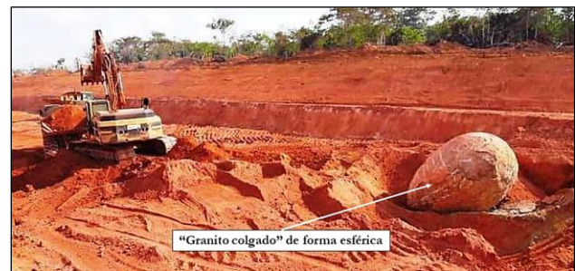
Figura 7 - Granito colgado de forma esférica expuesto luego de los trabajos de laboreo y limpieza de la trinchera para la vía férrea en el Bloque 9. La retroexcavadora CAT modelo 320 sirve de escala. Imagen: Indira Wagner, 2020.
