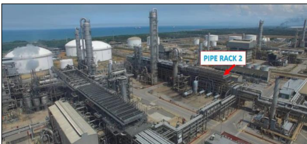
Figura 11. Instalación industrial y estructura de Pipe Rack
