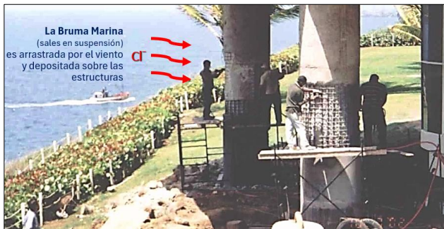
Figura 30. Ambiente marino: alta salinidad tanto del agua como del aire. Bruma marina, aerosoles de agua de mar transportados tierra adentro por la brisa. Altas temperaturas
