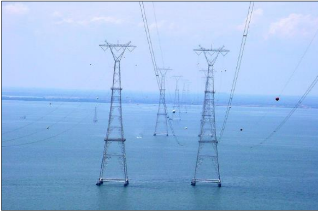
Figura 5. Torres de transmisión eléctrica construidas en el lago de Maracaibo
