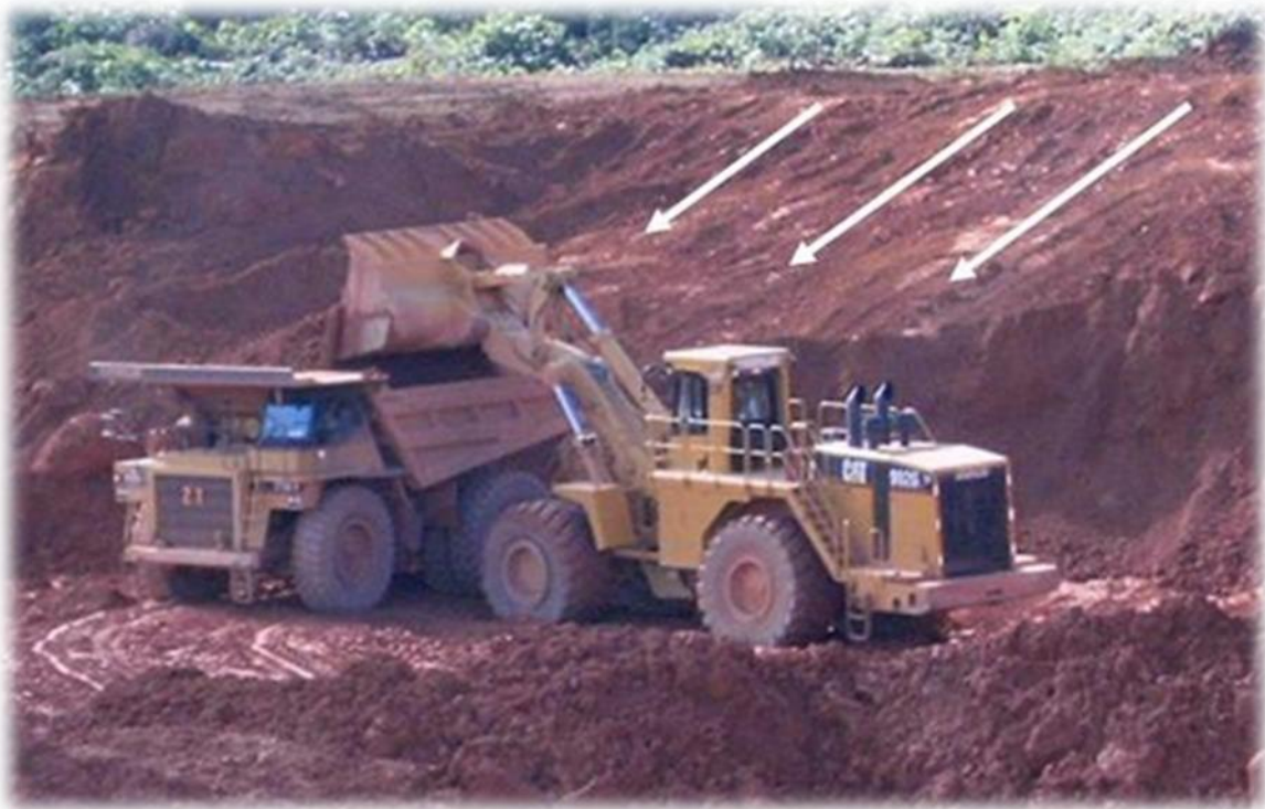
Figura 23. Carga de camión de 100 t con cargador frontal de 10 \text{ m}^3 de balde. El material que ha sido empujado ladera abajo por tractores, como indican las flechas. Observe el incremento de humedad en el piso operativo o de trabajo, cuando se utiliza la combinación tractor - cargador. Foto autor: Noel Mariño, año 2003.
