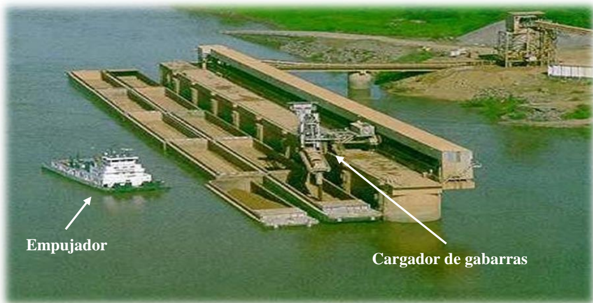
Figura 29. Muelle de El Jobal, con una longitud de 240 m sobre el río Orinoco y el cargador de gabarra móvil en operación, en una fila doble de gabarras, con una capacidad de 3600 t/h. Foto autor: CVG BAUXILUM.
