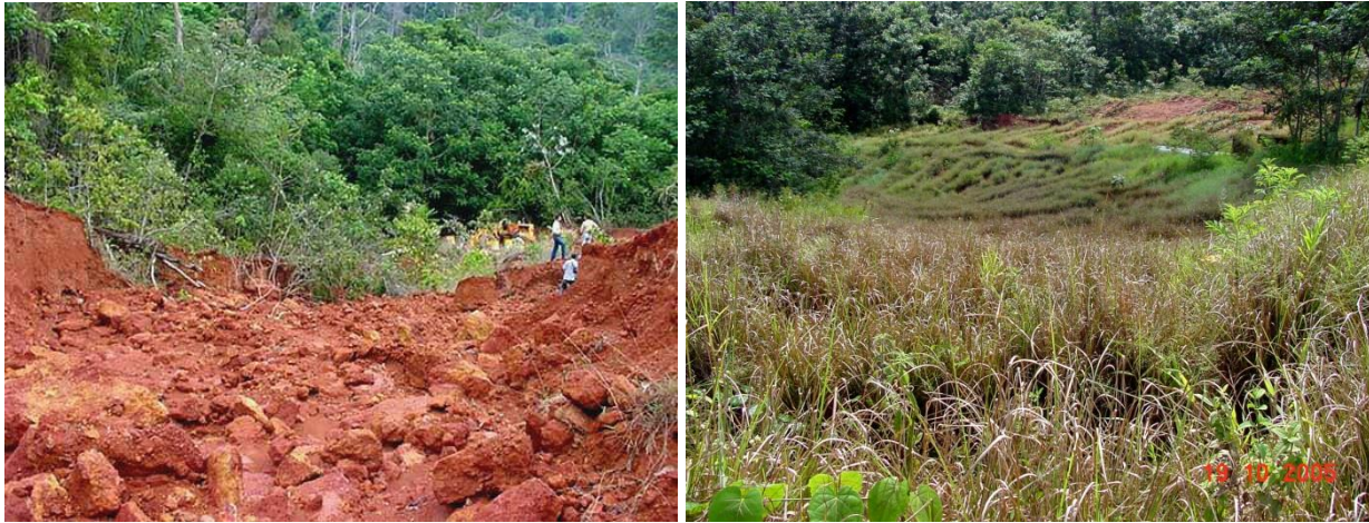
Figura 37. Cárcava “Chorro de Agua”, en la vialidad que conduce a la mina de bauxita de Los Pijiguaos: Antes (2003) y después (2005) de la siembra de vetiver, que trajo como resultado, la recuperación de una zona altamente afectada por la erosión. Autor fotos: Rafael Luque, año 2005.
