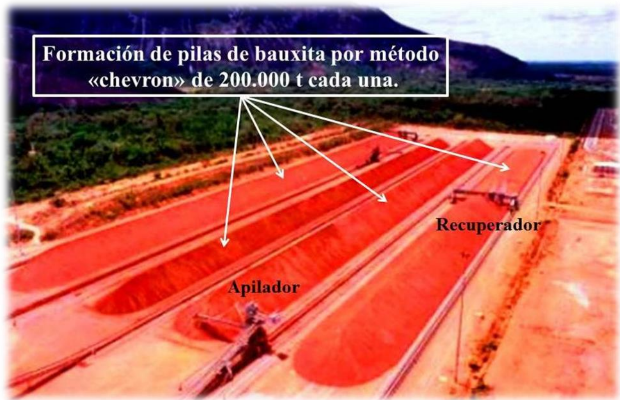
Figura 17. Formación de pilas de hasta 200.000 toneladas, por método “ chevron ”, en los patios de almacenamiento de Pie de Cerro, en CVG Bauxilum Los Pijiguaos, en el verano del año 2001. Se observan los equipos: apilador, que trabaja a 1600 toneladas/hora (t/h) promedio y el recuperador, con una tasa máxima de 3600 t/h. Foto CVG BAUXILUM, año 2001.
