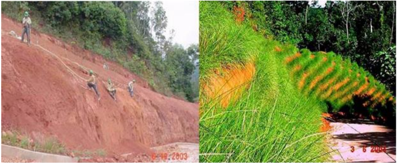
Figura 33. Protección de taludes, en vías de tránsito de fuerte pendiente, con problemas de caída de bloques de piedra. Antes (izq.) y después (der.) de la estabilización del talud con vetiver. Autor fotos: Rafael Luque, años 2003-2004.
