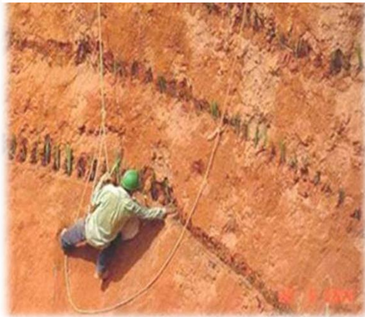
Figura 33. Protección de taludes, en vías de tránsito de fuerte pendiente, con problemas de caída de bloques de piedra. Antes (izq.) y después (der.) de la estabilización del talud con vetiver. Autor fotos: Rafael Luque, años 2003-2004.
