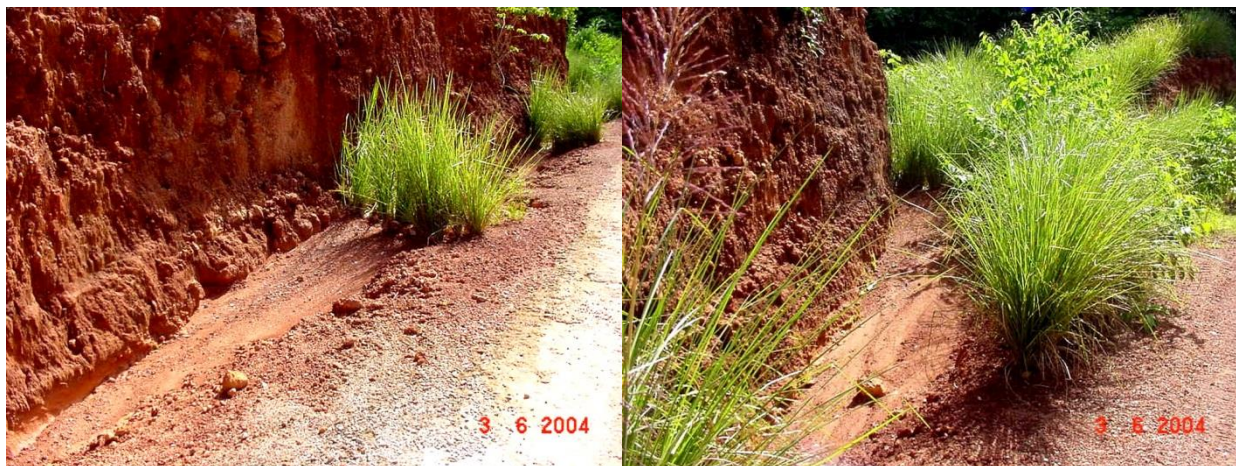
Figura 36. Filtro de racimos de vetiver para atrapar los sedimentos lateríticos en las cunetas y evitar su incorporación a los cauces de la cuenca. Autor fotos: Rafael Luque, año 2004.
