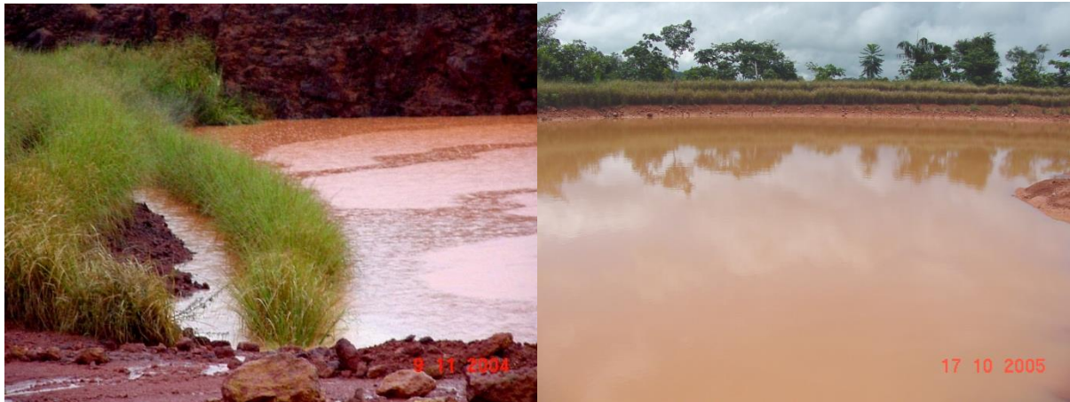
Figura 35. Protección de diques con vetiver en lagunas de sedimentación. Estas lagunas contienen los sedimentos lateríticos, como contaminantes físicos, resultantes de las operaciones mineras. Autor fotos: Rafael Luque, años 2004-2005.
