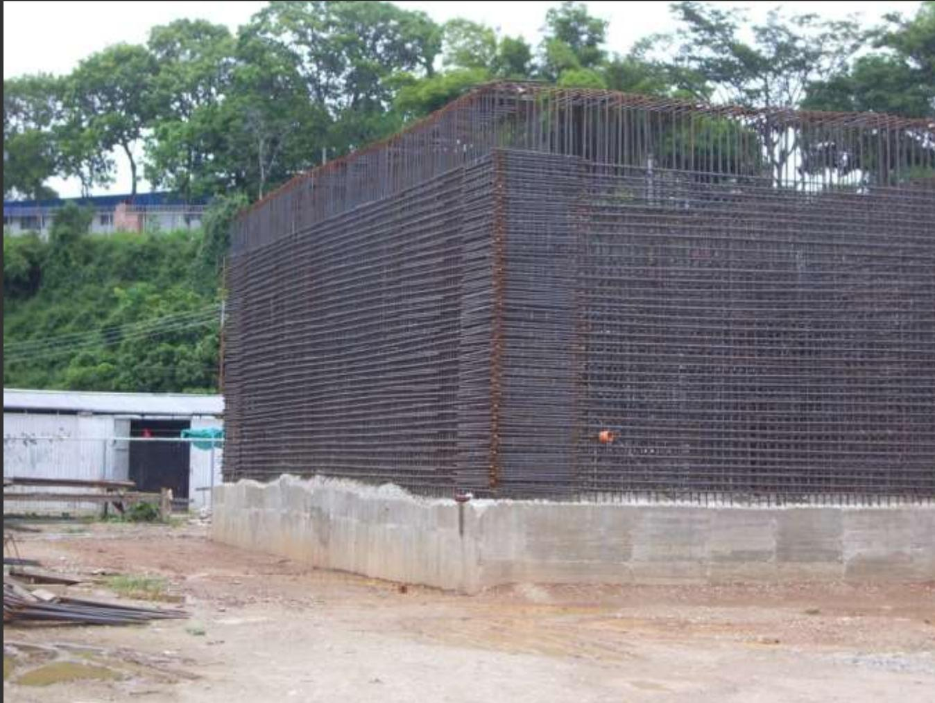
Paredes, piso y techo de 1.30 m de espesor de concreto armado para protección contra las radiaciones ionizantes (rayos gamma)
