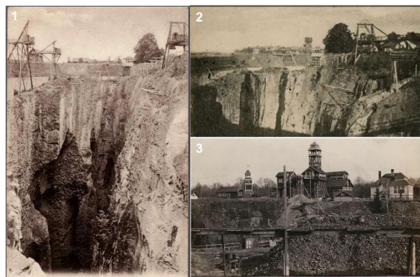
Figura 13. Fotografías tomadas en los años 1898 (1), 1899 (2) y 1915 (3), donde se aprecian varias imágenes de la boca de la mina de Dannemora con las diversas grúas externas presentes (1, 2), tal como fueron ilustradas por el artista sueco Elías Martín a fines del siglo XVIII. En la imagen (3) se observa el ascensor de Örnén existente en esta mina, junto a la cabina minera y la vialidad ferroviaria que data del año 1878 para el traslado del mineral de hierro.
