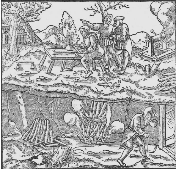
Figura 19. Imagen que ilustra el calentamiento directo sobre la roca mediante el uso de leños de madera en las galerías subterráneas en el siglo XVI para la obtención del mineral. Tomado de Agricola (1556)
