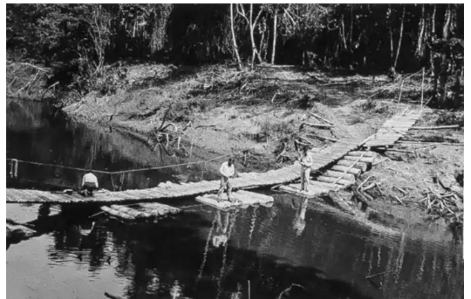
Figura 8. Construcción de un puente flotante para atravesar el río Victoria (Concesión Barco). Datatio incerta entre 1932-1936. Fuente: Colombian History – The Barco Concession https://sites.google.com/view/barcoconcesssionhistory/home
