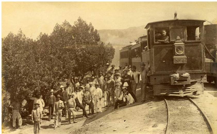
Figura 6. Locomotora No 4. Ferrocarril Caracas-La Guaira, 1883. Fuente. Cortesía Gregory Leroy Fine Photographs. Tomado de Olivar (2022).
