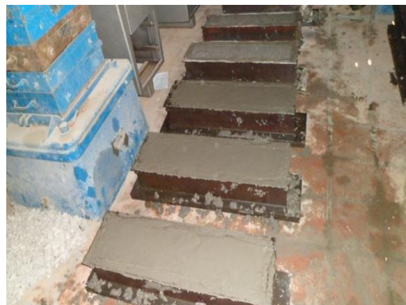
Figura 6. Viguetas vaciadas en los moldes correspondientes.
