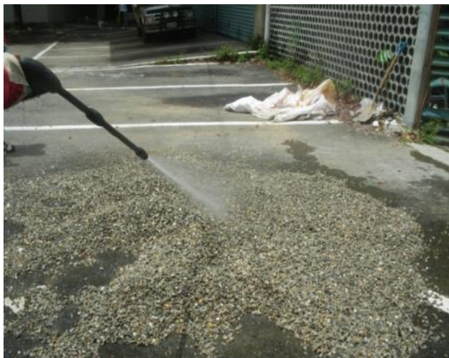
Figura 4. Lavado del agregado reciclado.
