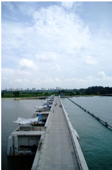
Fig. 7-15 El Puente Marina, que contiene las compuertas de presión que forman la barrera del Dique Marina en Singapur (Autor: TimLee90, 2008. Lic. Creative Commons BY-SA ) 172 .
