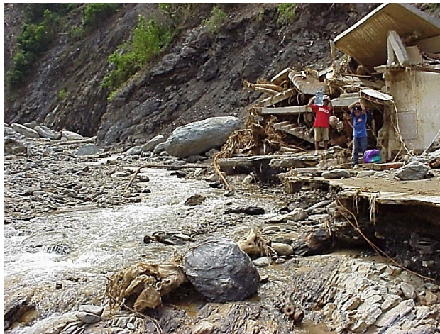
Fig. 5-16 Viviendas de mampostería destruidas en Carmen de Uria.
