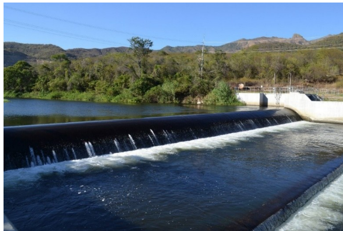
Fig. 6-5 Presa Derivadora El Cercado. Proyecto Río Ranchería, La Guajira, Colombia (Autor: Alejandrorestrepouribe, 2013. Lic. Creative Commons BY-SA 4.0 ) 132 133 .
