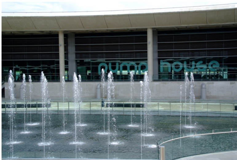
Fig. 7-14 Dique Marina, con la Casa de Bombas al fondo que alberga siete bombas de gran caudal (Autor: TimLee90, 2008. Lic. Creative Commons BY-SA 3.0) 169 .
