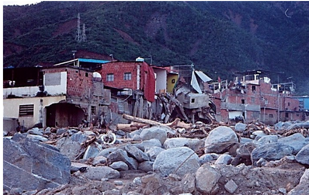
Fig. 5-15 Viviendas de mampostería destruidas en Carmen de Uria.
