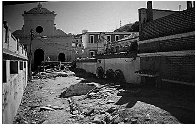
Fig. 5-27 Daños en el casco histórico de La Guaira.
