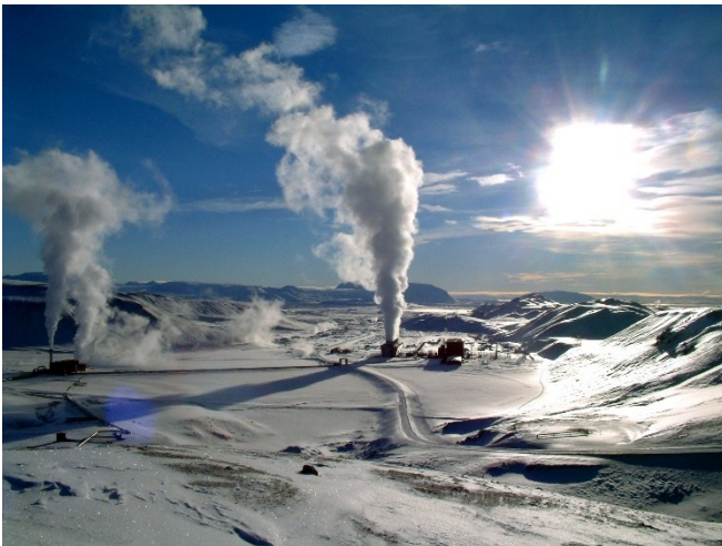
Fig. 8-7 Planta geotérmica Krafla en Islandia (Autor: Ásgeir Eggertsson, 2004. Lic. Creative Commons Attribution-Share Alike 3.0 ).
