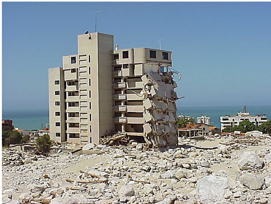
Fig. 5-13 Destrucción de edificaciones en Los Corales por arrastre de rocas.
