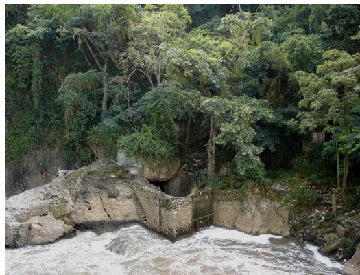
Figura 11. Restos de las obras de aducción para la captación de las aguas del río Guaire destinadas a la Planta Eléctrica de El Encantado, ubicados aproximadamente 700 m aguas abajo de la Cueva de El Encantado. 2004.
