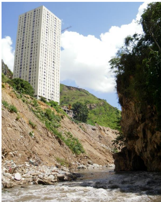
Figura 10. Vista del Río Guaire. A la derecha aparece el afloramiento de mármol donde se abre la Cueva del Indio de El Encantado. A la izquierda toda la ladera es un bote de escombros que altera la sección del río, ocasionando la elevación del cauce. Al fondo uno de los edificios del conjunto Paulo VI.
