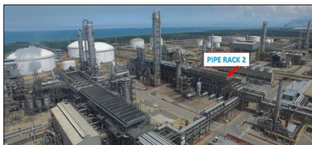
Figura 11. Instalación industrial y estructura de Pipe Rack
